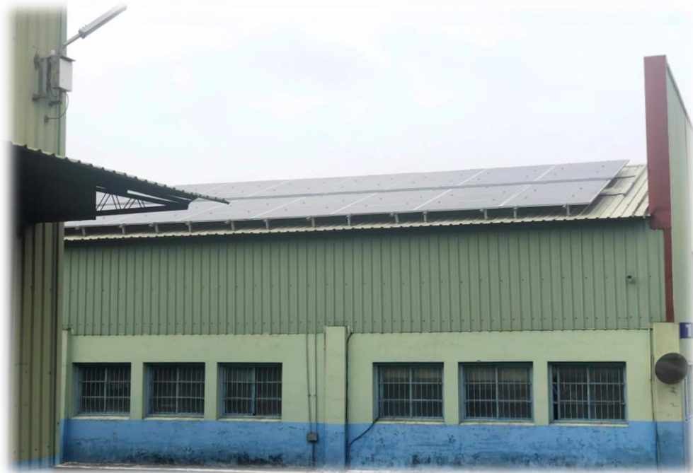
▲ 新化廠區屋頂架設太陽能板
