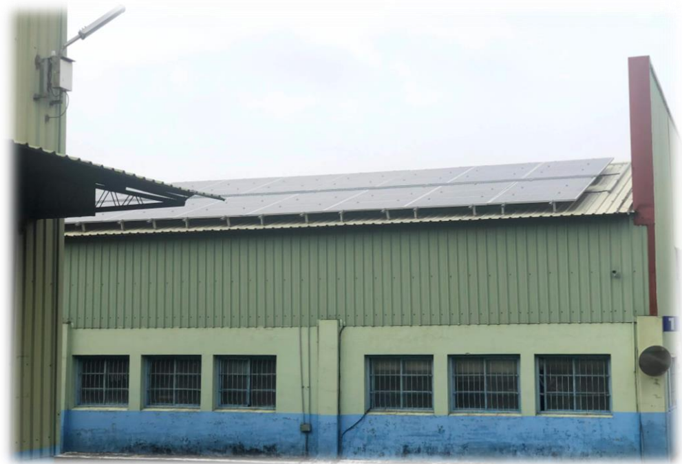
▲ 新化廠區屋頂架設太陽能板
