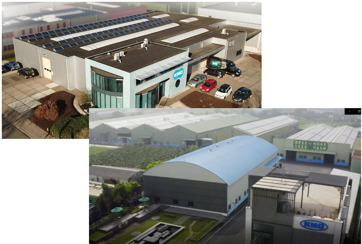
▲ 台灣廠區及歐洲公司屋頂架設太陽能板
