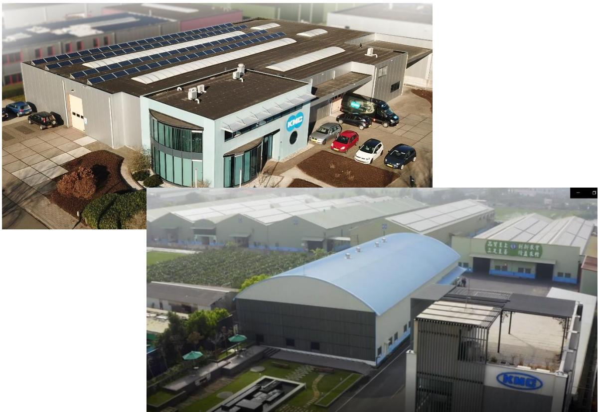
▲ 台灣廠區及歐洲公司屋頂架設太陽能板
